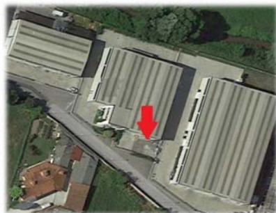
Terzo capannone sulla destra
